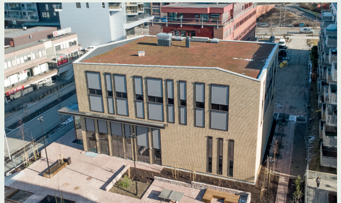
Taket på nybygget er beplantet med sedum for å fordøye regnvann.
